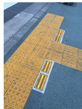
徳島二軒屋交差点に敷設した新たな点字ブロック
